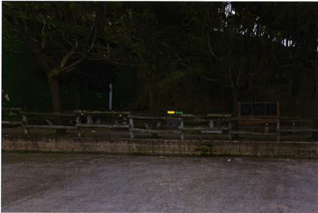
Instalación de nuevas papeleras.
