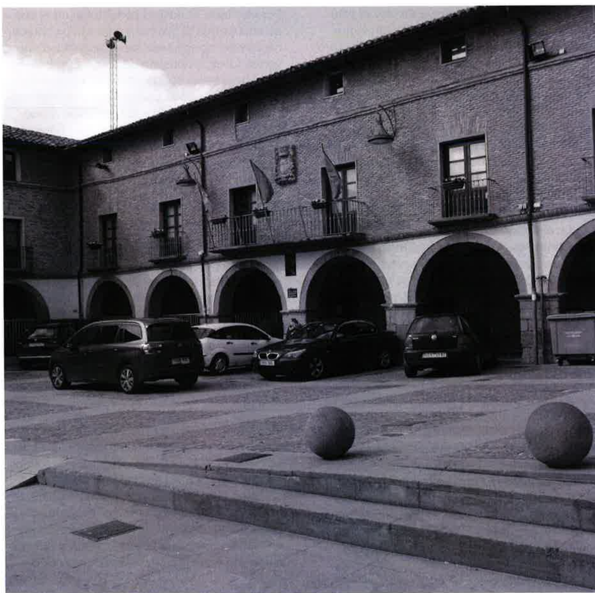
Plaza de los Fueros y edificio de la casa consistorial. Fuente propia
